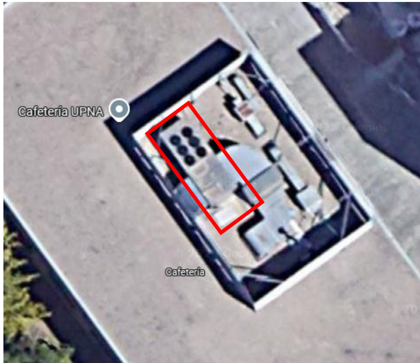
Situación Roof Top en cubierta
