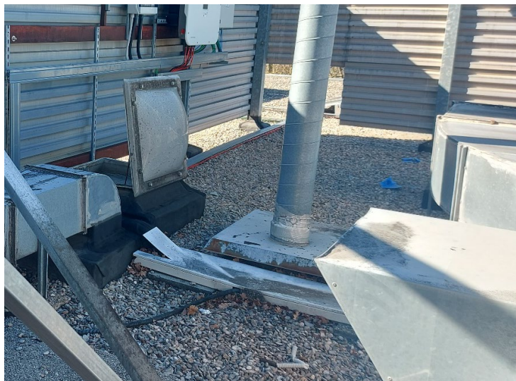
Subida del cableado a cubierta
